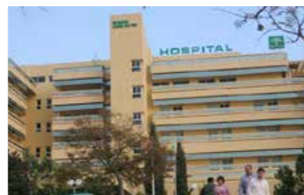
Hospital Costa del Sol, Marbella.
